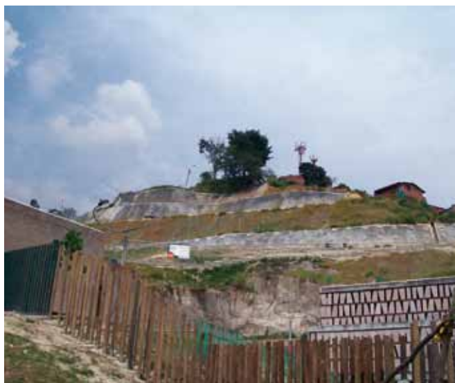
Barrera de contención en zona minera.
