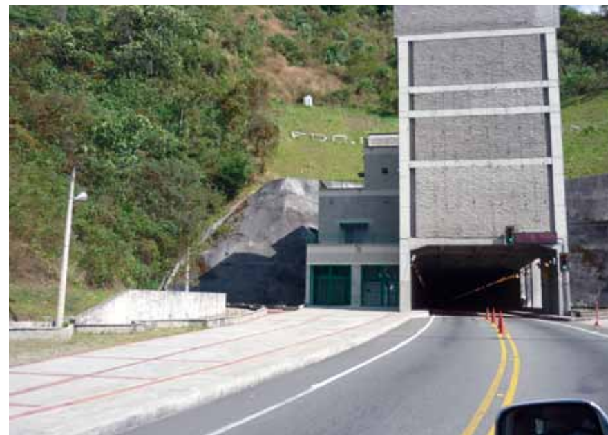
Boca occidental de ingreso al túnel.
