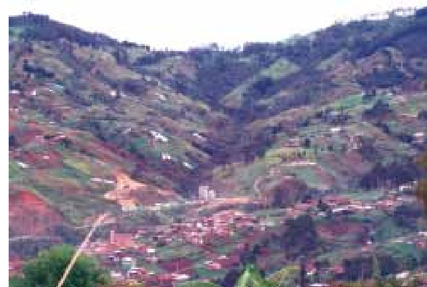
Fisiografía veredal y vía de ingreso al túnel de occidente.
