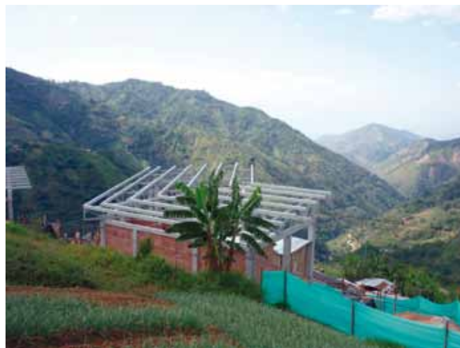
Estación del cable y huerta productiva.
