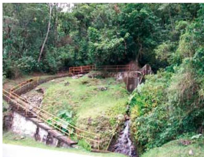
Obras de captación para el acueducto veredal.
